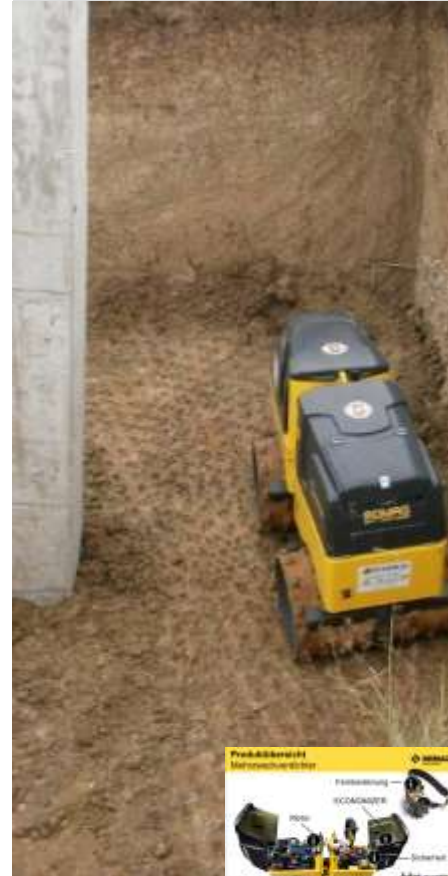
Trabajos de cimentación
