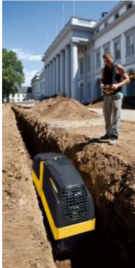
Obra civil para canalización
